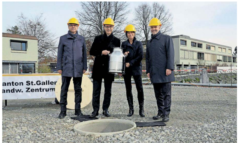
Gemeinsam versenkten der LZSG-Leiter Markus Hobi, Regierungsrat Marc Mächler, Regierungsrätin Heidi Hanselmann und Regierungsrat Stefan Kölliker die Milchtanse mit Zeitdokumenten auf der Baustelle des Neubaus der Landwirtschaftsschule. Bild: Corinne Hanselmann
